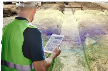
⑦ 建設測量
